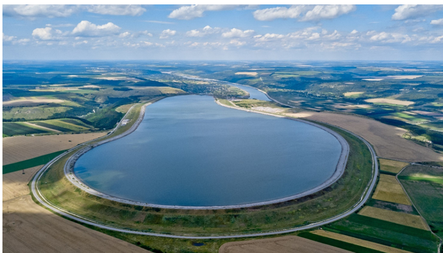
Рис. 2. Вид на верхню водойму дністровської ГАЕС (Ukrhydroenergo ... 2024)
